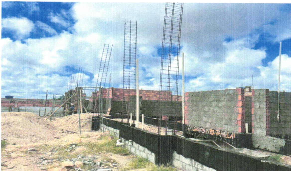
FOTO 06 – Armação de aço CA-50 Ø 10mm; incluso fornecimento, corte, dobra e colocação
