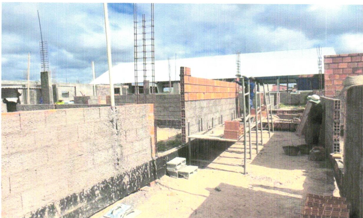
FOTO 10 – Armação de aço CA-60 Ø 5,0mm; incluso fornecimento, corte, dobra e colocação
